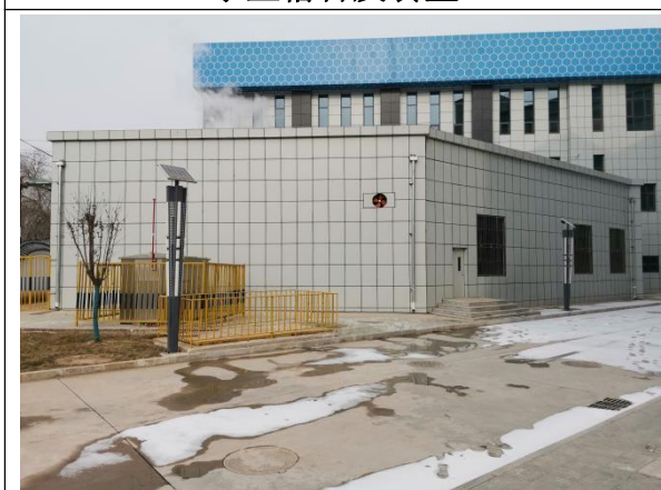
锅炉房及游泳馆
