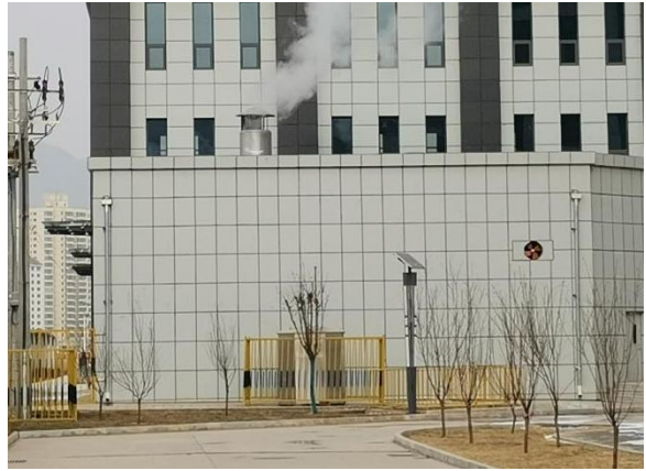
锅炉房排气筒
