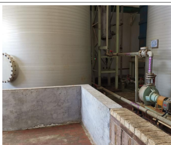
盐酸储罐围堰
